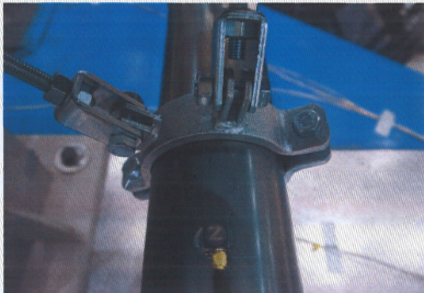
Photo B.17 시험 후 UUT-1 흔들림방지버팀대(근접)
