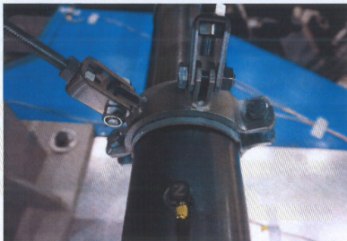
Photo B.21 시험 후 UUT-3 절연체 설치상태
