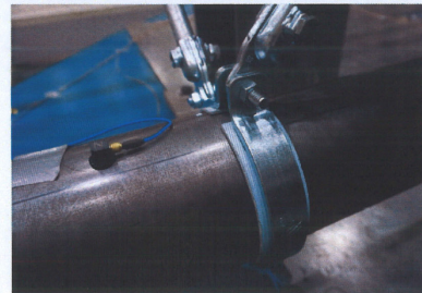
Photo B.22 시험 후 UUT-4 절연체 설치상태
