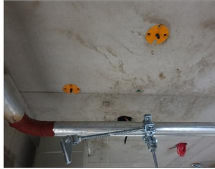
3) 지지대 길이(세장비고려) 및 설치각도 확인하여 앵커볼트 위치 선정(마킹작업)
